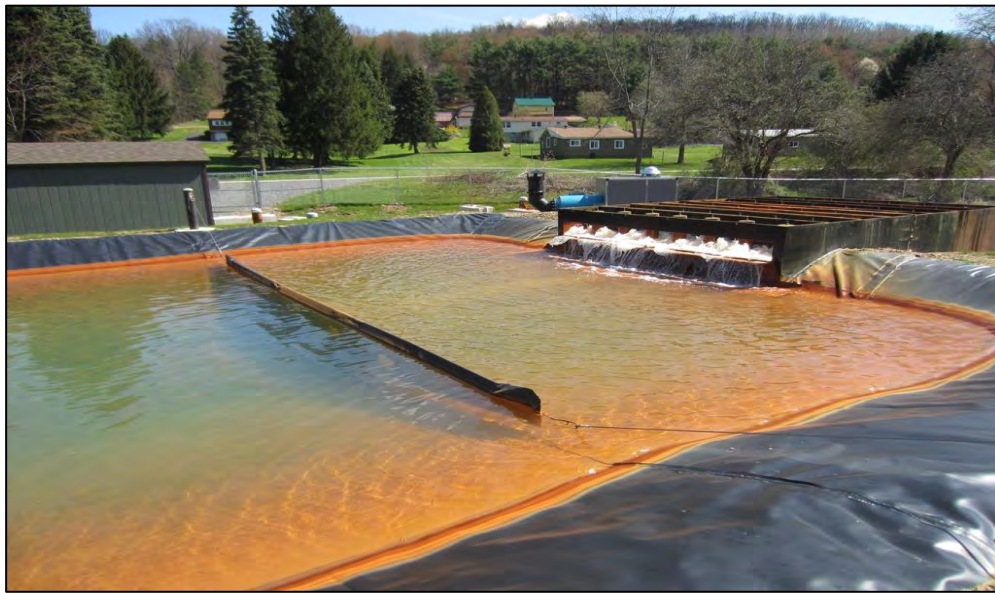
Figura 14 "Depósito de fluido de retorno en Pad Pits o Liners en Pennsylvania"
