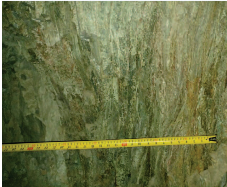
FIGURA 5.14: Fotografía de un pilar en la que se observa un dique riolítico intensamente propilitizado. Se aprecia el flujo bandeado relicto de la riolita.
