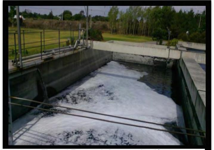
**Figura 2 Tanque de homogenización**
