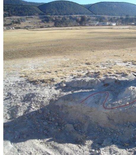
Figura 5.7. Evidencias morfológicas de rupturas cosísmicas recientes en los sedimentos y estructuras de la cuenca de San Pedro El Alto: desniveles verticales, escarpes de falla, afectación en estructura planar.
