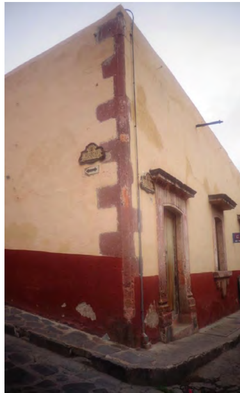
Fig. 30 Detalle de bloques de cantera en una finca de la calle Recreo esquina con calle Huertas. Foto de Ruth Olvera, 2016.
