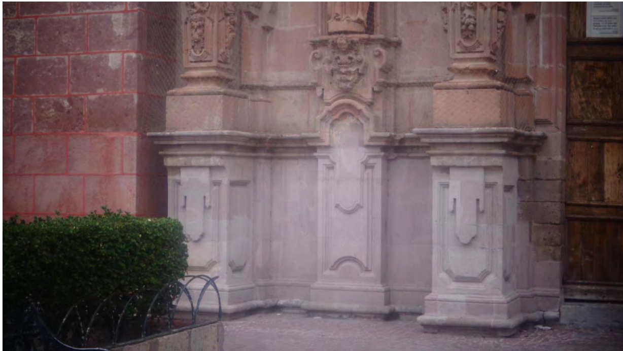
Fig. 41 Detalle de la fachada del Templo de San Francisco. Observamos la base de las columnas, la cual tuvo una restauración en el periodo de 2000 – 2005. Es una de las iglesias que cuenta con mayor número de detalles de cantería en su fachada, entre los que se encuentran figuras de santos, cornisas y nichos. Consideramos que algún cantero participó, ha habido pocas intervenciones y trabajos de restauración para conservar en buen estado dichas piezas. Foto de Ruth Olvera, 2016.
