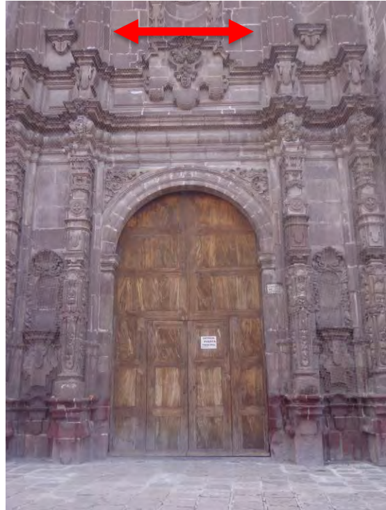
Fig. 36 Fachada lateral del Templo de San Francisco, en calle Juárez. El maestro cantero Javier Olvera y ayudantes intervinieron en el periodo 2000 - 2005 en las pilastras que se señalan con flechas. Foto de Ruth Olvera, 2016.
