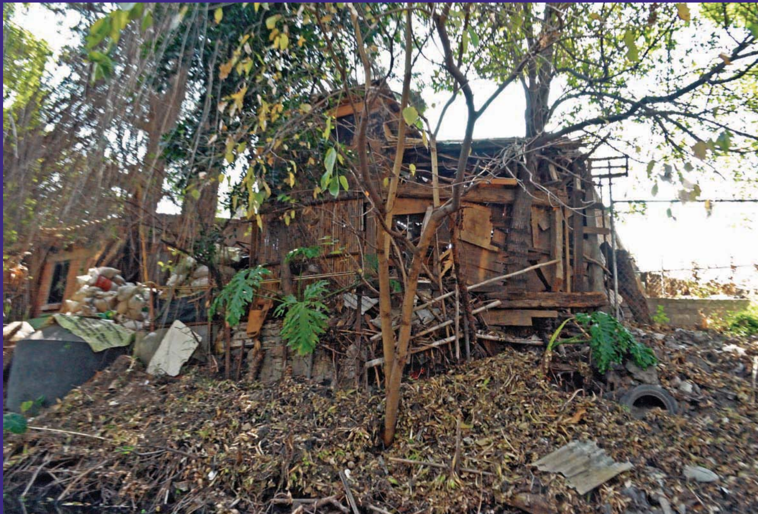
imagen47 Autoconstrucción a la orilla de los canales de Xochimilco, Mafer Tangerine
