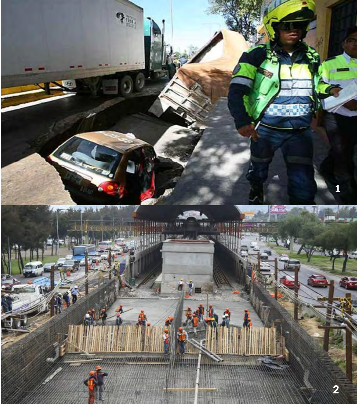
Figura 14. Daños geológicos ocasionados por la sobre explotación de los mantos acuíferos de la Ciudad de México.
