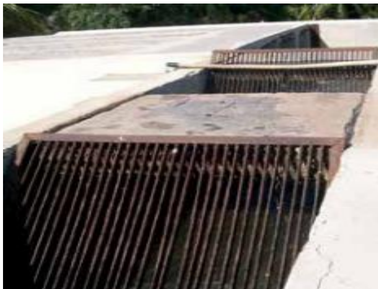
Figura 10. Equipo de limpieza manual (Fuente: Operación y Mantenimiento de Plantas de Tratamiento de Aguas, CONAGUA).
