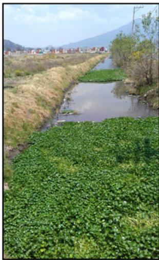
35) Dren de agua pluvial
