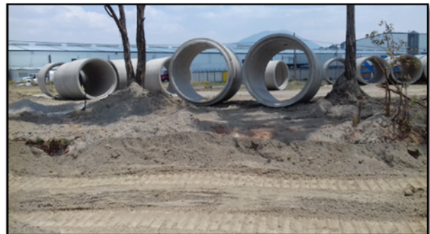
43) y 44) Instalación de sistema de alcantarillado sobre Calle Camino a Flor de María
