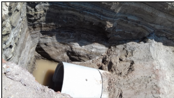
43) y 44) Instalación de sistema de alcantarillado sobre Calle Camino a Flor de María
