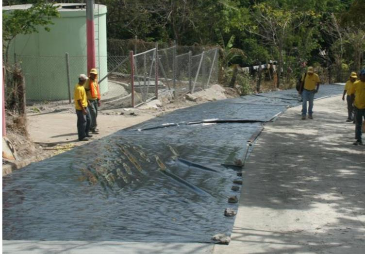
**Figura 22. Fotografía del curado de concreto permeable.**
