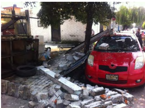
Imagen 2.2. Derrumbes cobraron vidas y pérdidas materiales.
