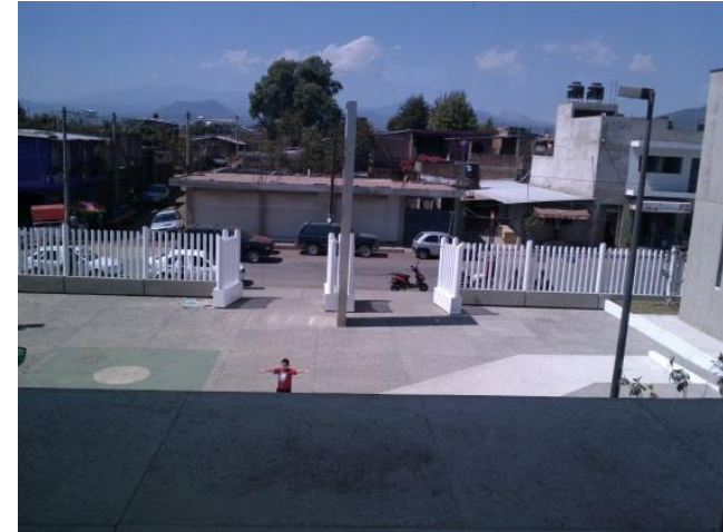
Vista plaza de acceso a la Unidad Médica Familiar N°81.
