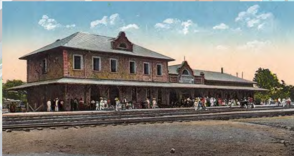
Fuente: www.mexicoenfotos.com Antigua Estación de Ferrocarril de Cuernavaca
