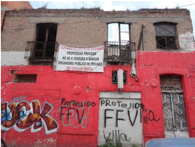
Fig. 84. Fachada del inmueble No. 239 sobre la calle de Fresno.
