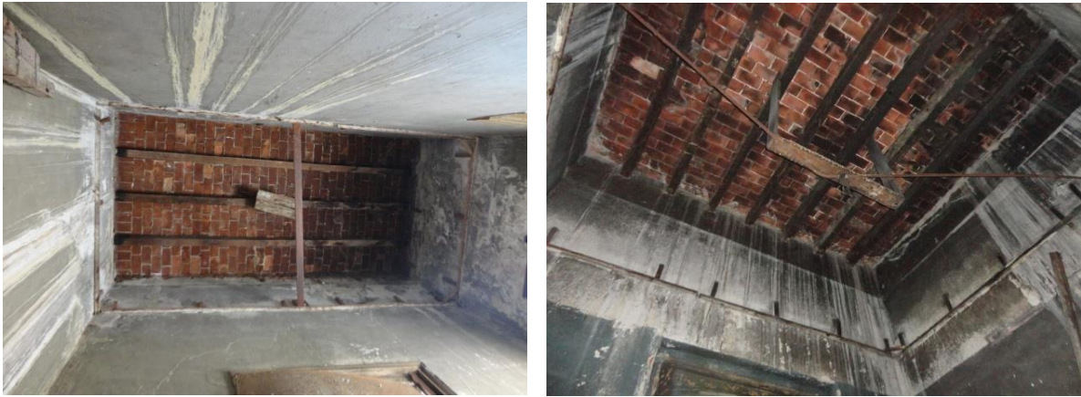
Fotos No. 71-72. Sistema constructivo en cubiertas de una fábrica de velas. Fuente: fotos del autor, 2016. En la antigua fábrica de velas "La Industria Nacional", se observa el ladrillo en las azoteas, la utilización de este material fue importante.
