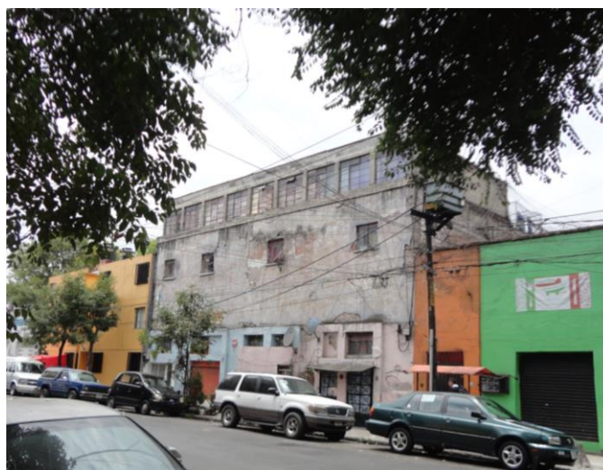
Fig. 90. Inmueble sobre la calle de Fresno No. 164.
