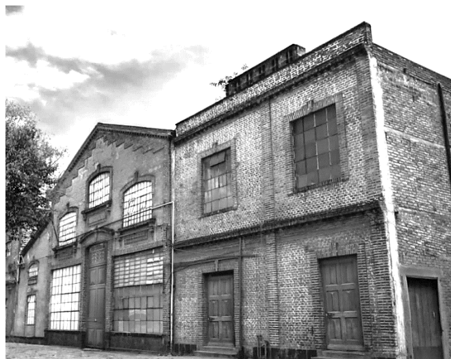
Fig. 29. Fachada de la nave de producción de "La cubana"
