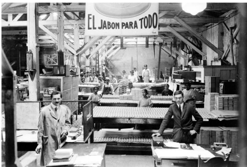
Fig. 22. Fábrica de jabón en la Santa María la Ribera, 1920. Fuente: Fototeca del INAH, Archivo de Colonias, Santa María la Ribera, 2015. Los procesos de producción eran adaptados al espacio determinado por la construcción ya edificada.
