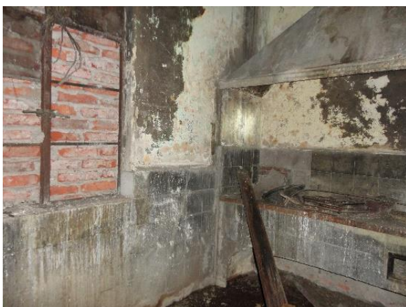
Fig. 97. Cocina que aún se conserva en la parte correspondiente al edificio de siglo XIX. Fuente: foto del autor, 2015. Como en este espacio, la mayoría de los locales presenta desprendimiento de aplanados y humedades.
