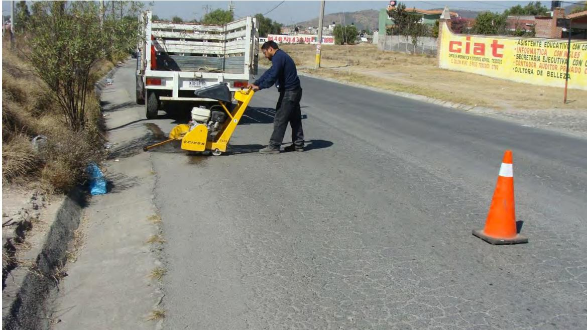
Foto N° 7.- Corte del pavimento en el km 2+500 PCA N° 2
