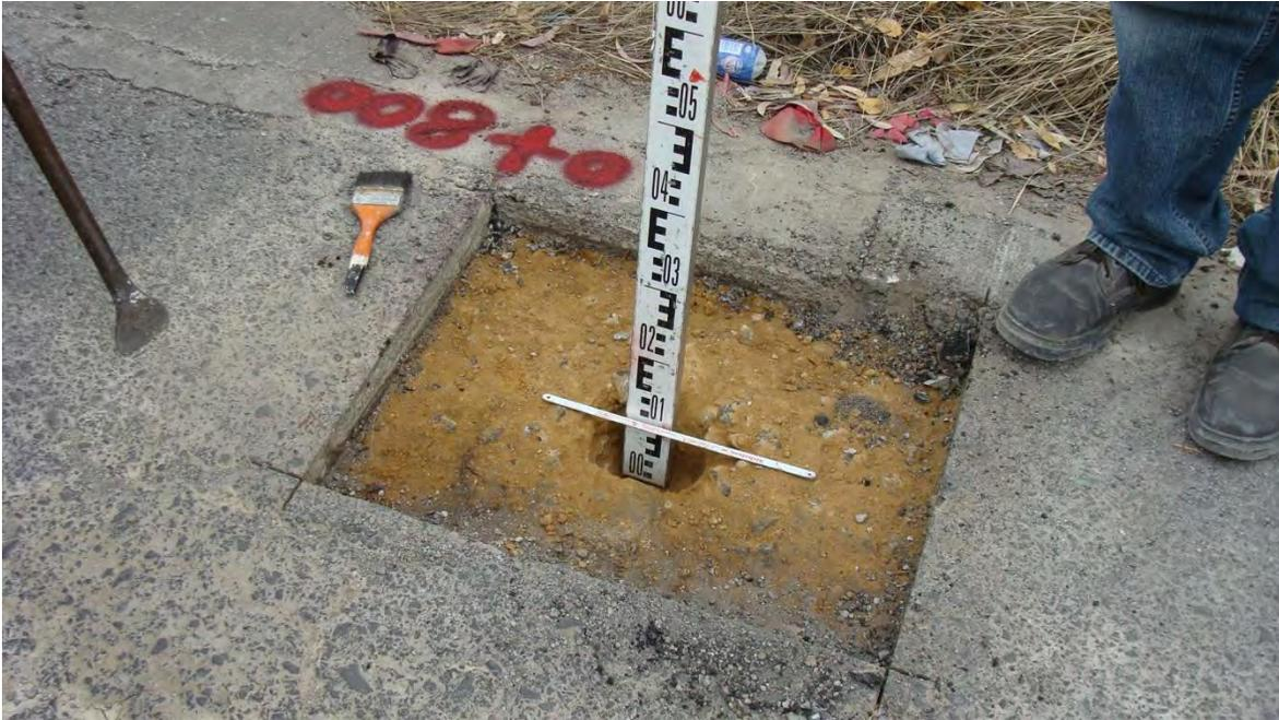
Foto N° 9.- Determinación del grado de compactación en el km 0+800. PCA N° 2
