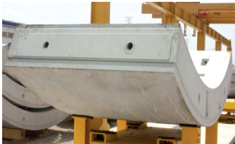
Figura 3.7 Junta plana de una dovela (Peña, 2012).
