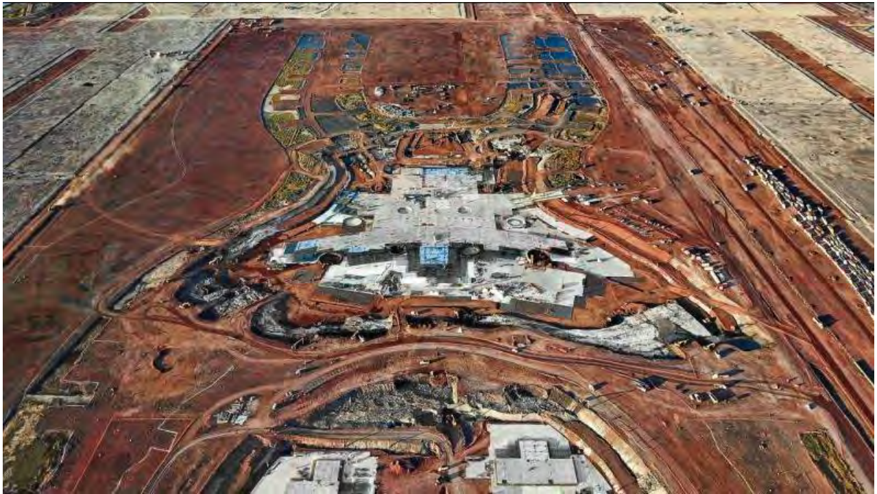
Figura 110.- “Excavación de la losa de cimentación de la terminal del NAICM, precarga de las pistas y zona a tratar con técnica de vacío (perímetro de la terminal). Fuente: Expansión, Diego Macía ”
