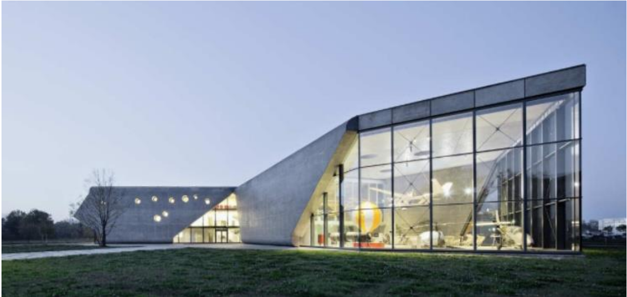
Vista Acceso Principal del museo (Parte remodelada).
