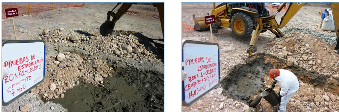
Figura 56. Tratamiento en una zanja de 0.5 m de profundidad.
