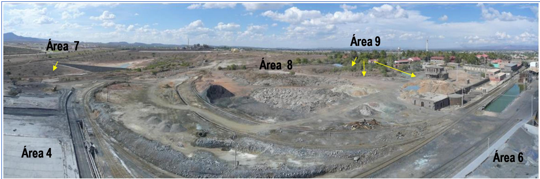
Fotografía panorámica de las áreas 8 y 9 de residuos que están a la intemperie en el predio de la Planta de Cobre
