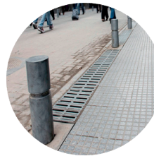
Bolardo cilíndrico de tránsito para separación de circulación peatonal y vehicular.
