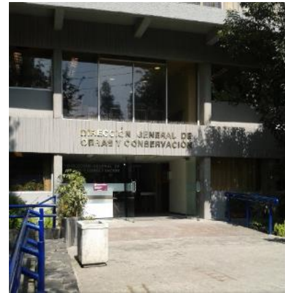
1.2.4.1: Dirección General de Obras y Conservación de la UNAM.
