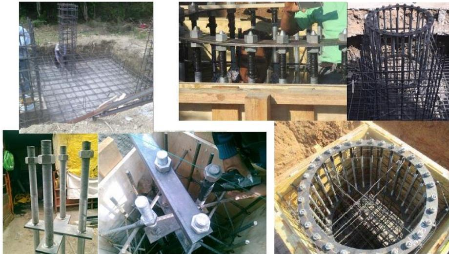
**Imagen 23.-** Kit de anclaje autosoportada / kit de anclaje monopolo.
