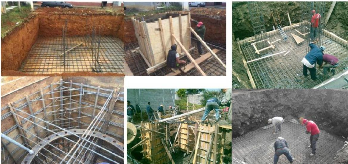
**Imagen 22.-** Armado de cimentación monopolo / armado de cimentación autosoportada.
