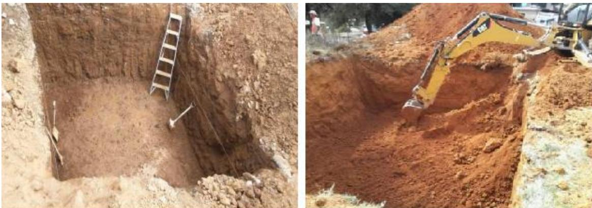
**Imagen 19.-** Excavación para monopolo / excavación para autosoportada.
