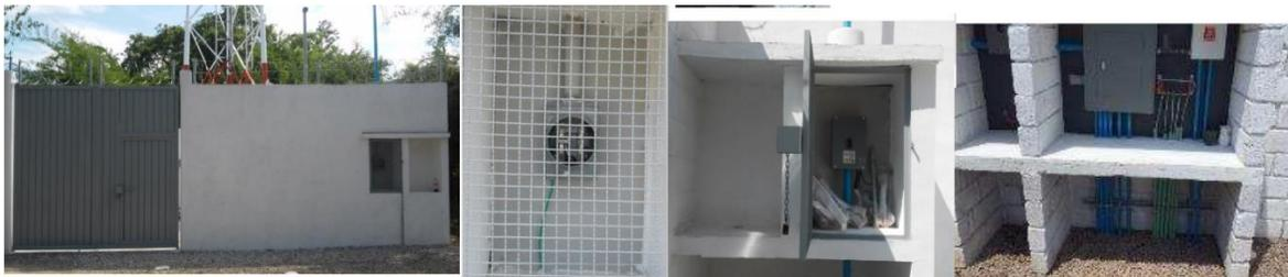
**Imagen 43.-** Nicho exterior e interior para medidor.
