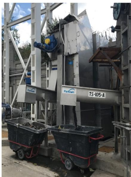
*Fig. 5. 2 Transportador de Sólidos, PTAN Valle de México*
