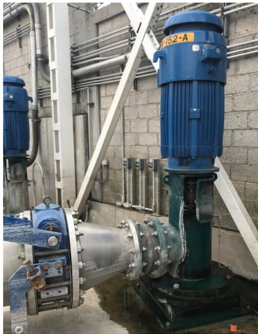
Fig. 5. 3 Bomba Vertical de Agua Negra, PTAN Valle de México
