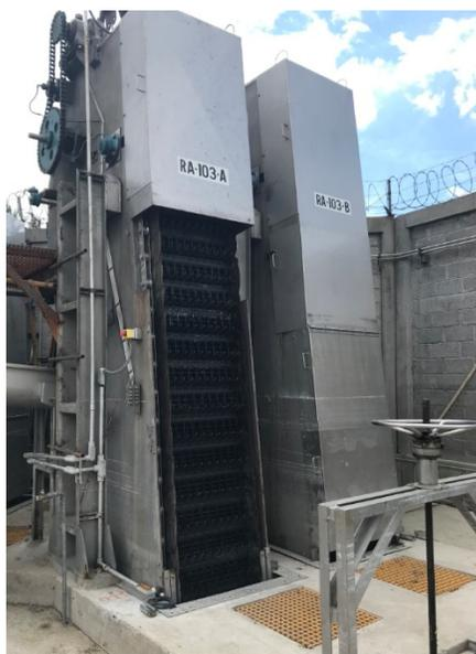
*Fig. 5. 1 Rejillas Automáticas, PTAN Valle de México*
