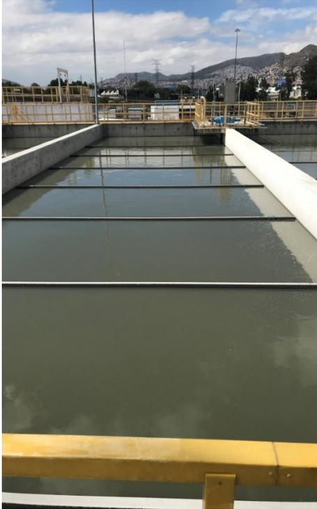
*Fig. 5. 6 Clarificador Primario, PTAN Valle de México*
