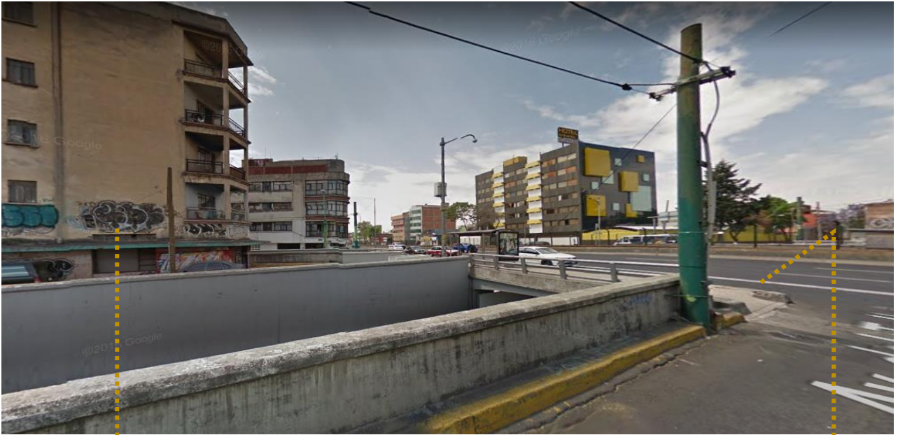
Edificio de vivienda
