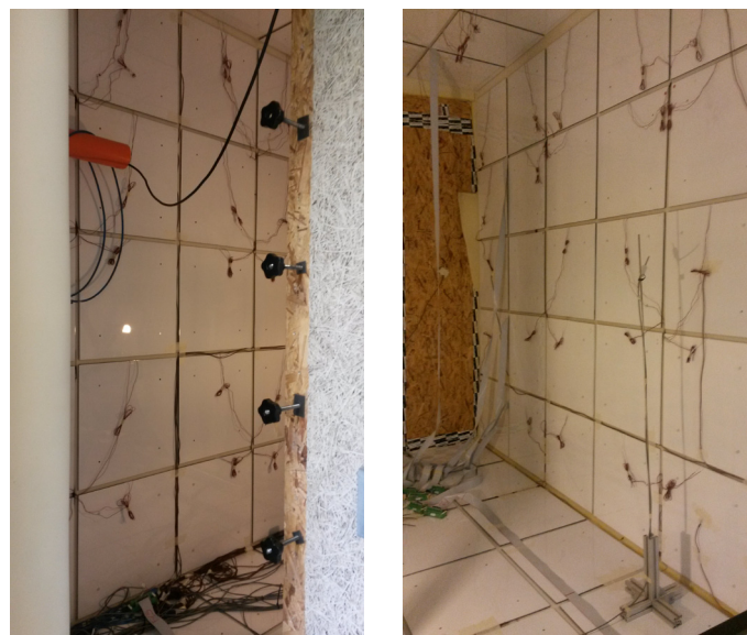
Figura 2.7. Vistas interiores de la cámara de prueba de la Test Cell. Fotografía del autor.
