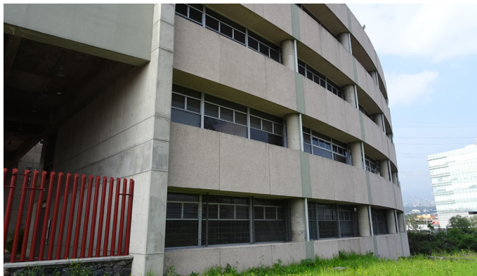
Figura 4.8. Fachada externa de las aulas. Fotografía del autor.
