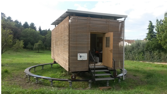
Figura 2.6. Vista externa de la Test Cell de Florencia. Fotografía del autor.
