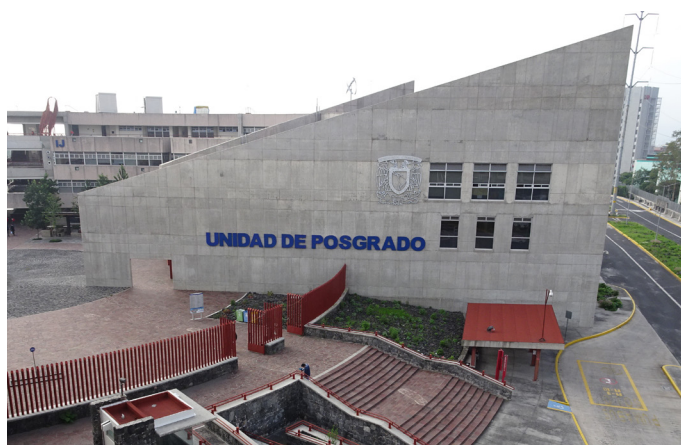
Figura 4.1. Acceso principal a la Unidad de Posgrado. Fotografía del autor.
