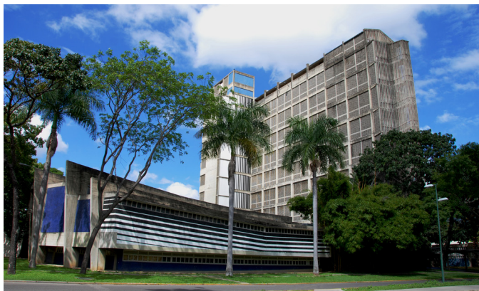
Figura 1.3. Vista general de la torre principal de la FAU-UCV.
