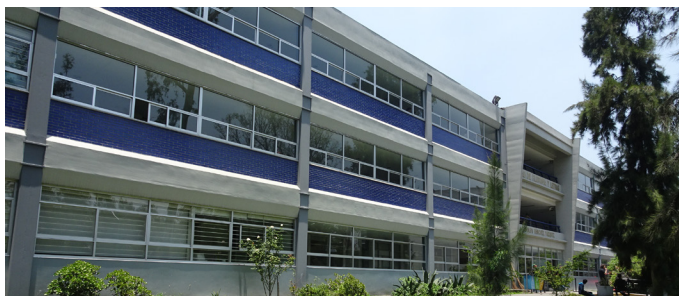
Figura 1.10. Fachada noreste del edificio “Adolfo Sánchez Vázquez”. Fotografía del autor.
