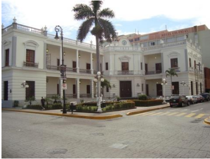
Palacio del Registro Civil
