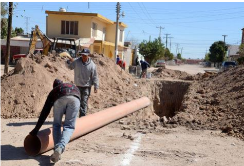
1.6. instalación de drenaje en Puerto Escondido. Imagen de internet www.puertoescondido.Gob.mx .
