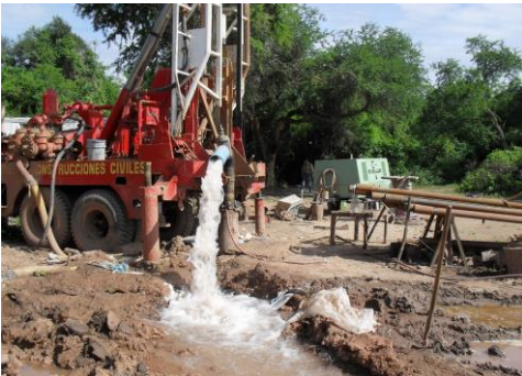
1.5. Perforación de pozo de agua en Puerto Escondido. www.puertoescondido.Gob.mx .
