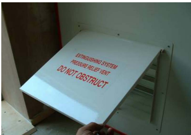
Figura 5.14 Ventila de relevo de presión
