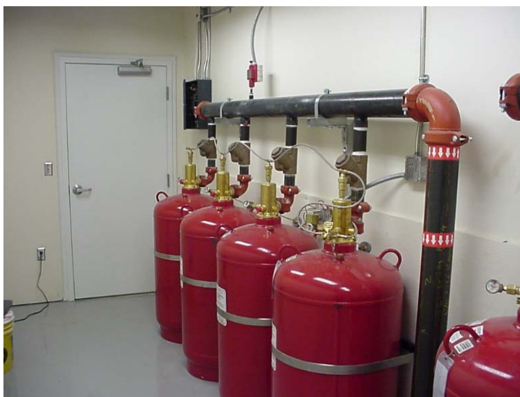
Figura 5.4 Cilindros que contienen agente limpio
