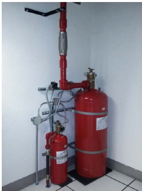
Figura 2.6 Cilindros de agente limpio (FM-200®)
