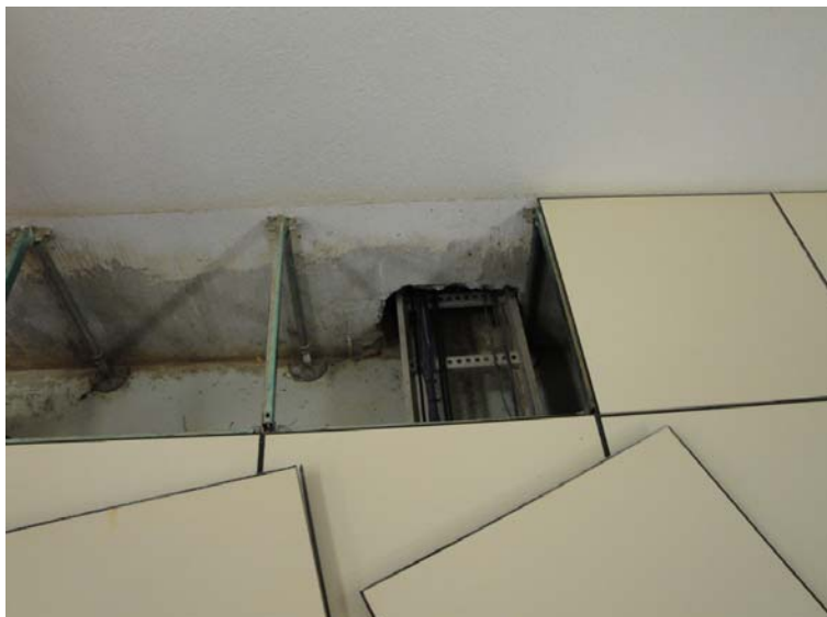
Figura 5.10 Los orificios dentro de un cuarto protegido pueden disminuir el desempeño del sistema de agente limpio.
