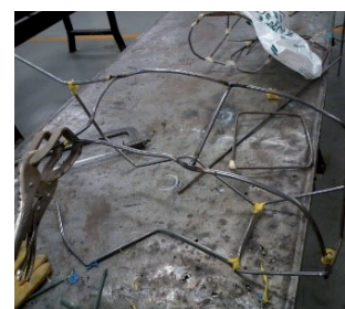
Fig. 123. Ensamblaje de varilla doblada (proceso 1).
