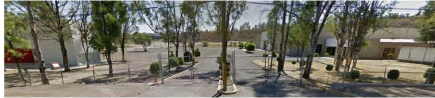
Acceso al predio
