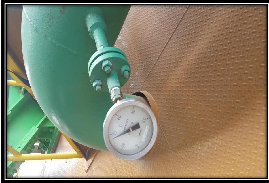
*Imagen 11. Termómetro Bimetálico.*
