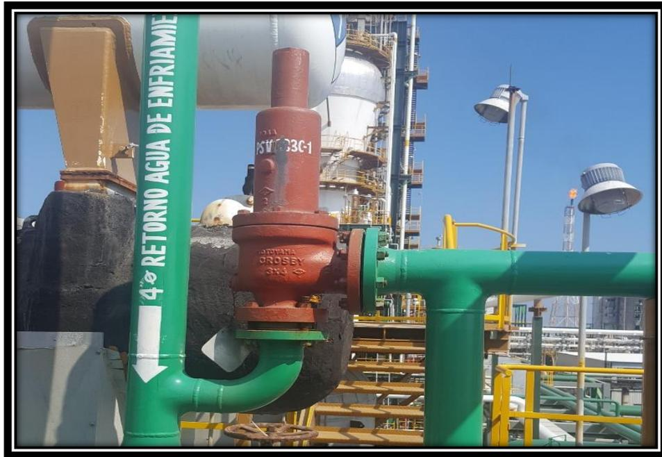
*Imagen 25. Válvula de Seguridad.*
