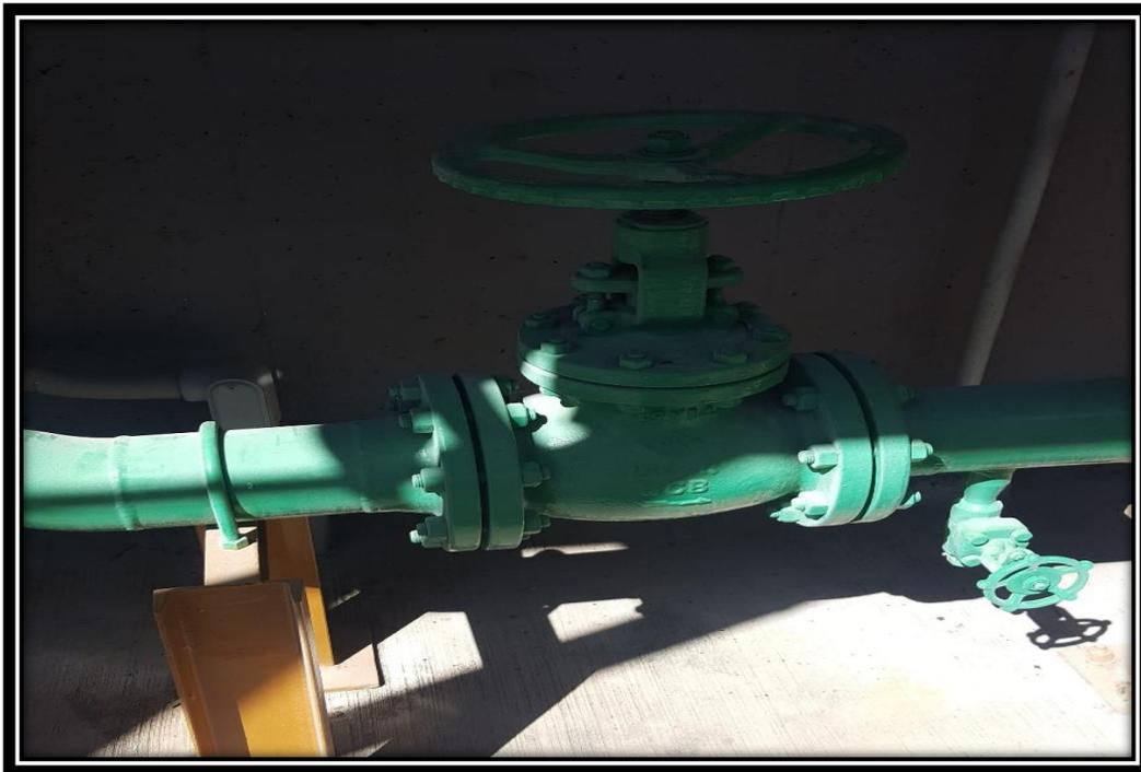
*Imagen 16. Válvula de Compuerta.*
