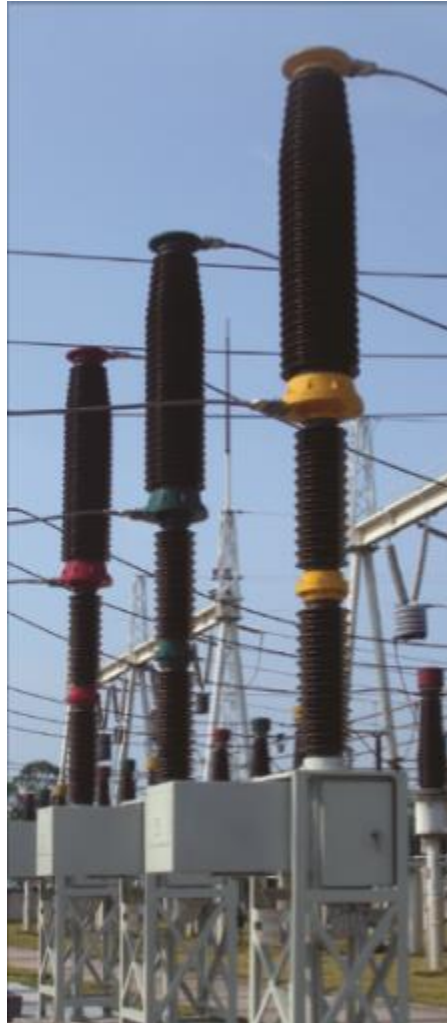
Fig. 2-15 Interruptor SF6 de tanque vivo de 252 kV.
