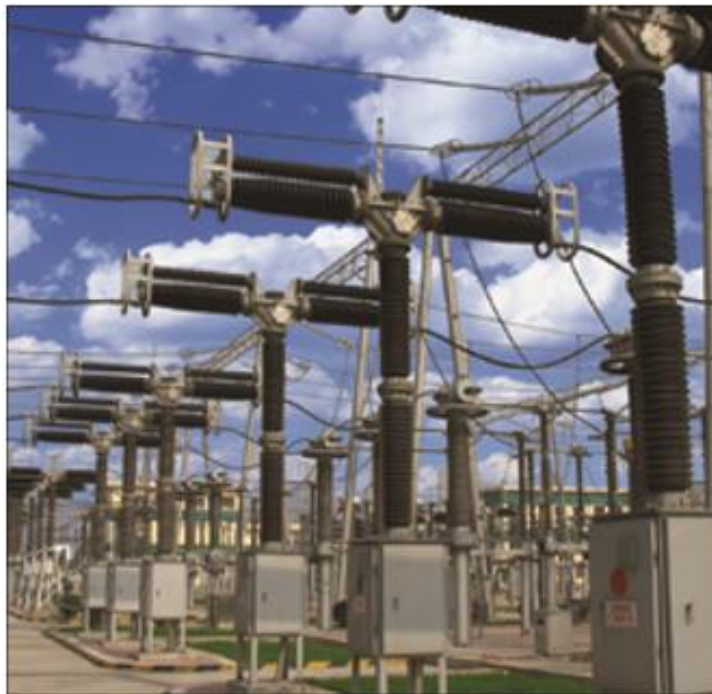
Fig. 2-30 Interruptor en gas SF 6 tipo tanque vivo de 363 kV.
