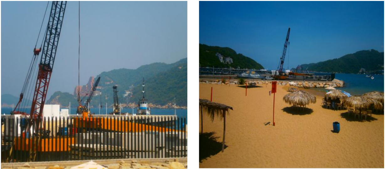
Figura 4.5 Construcción del puerto privado Marina Majahua en la bahía de Puerto Marqués. Fuente: fotografía tomada por la autora en junio de 2015.
