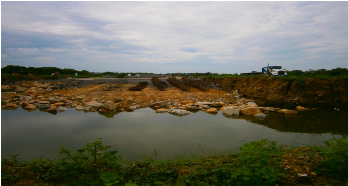
Figura 2.33 Trabajos realizados por las inmobiliarias en la zona de humedal. Fuente: fotografía tomada por la autora en junio de 2014.
