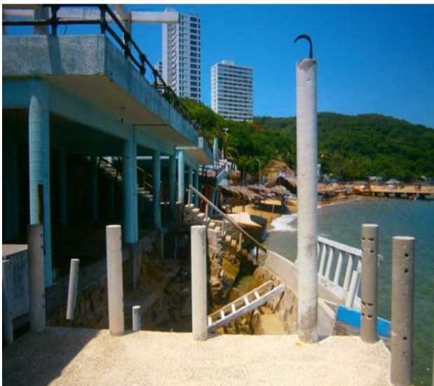
Figura 4.7. Restaurantes dañados en Puerto Marqués a raíz de la construcción del puerto Marina Majahua. En las fotos se puede observar los daños de la tormenta Manuel en 2013 y de Mar de fondo en 2015, debido a los rellenos del suelo marino la playa ha quedado más expuesta a ciclones, mareas y mar de fondo. Fuente: fotografía tomada por la autora en junio de 2015.
