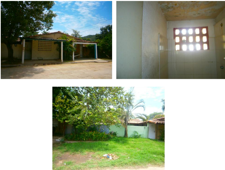
Anexo 4.16 Acondicionamiento y reforzamiento de las casas. Fuente: fotografías tomadas por la autora en junio de 2015
