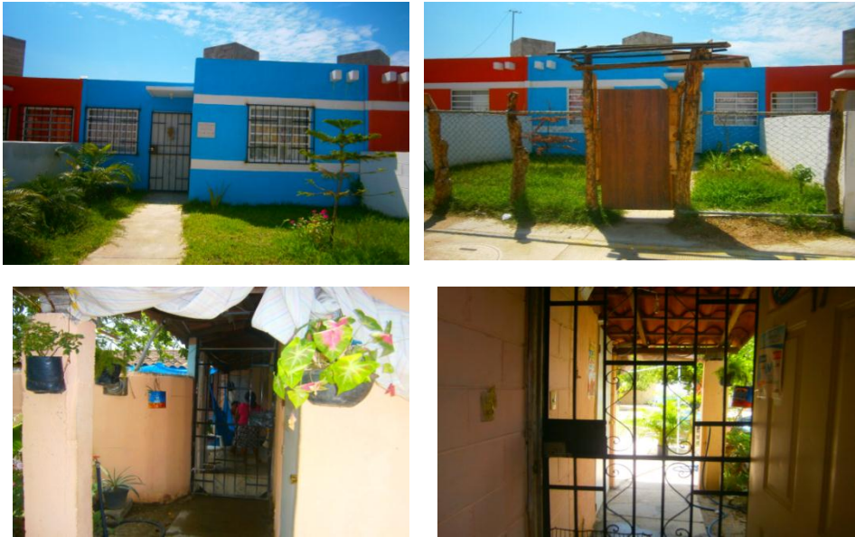
Anexo 4.15 Reforzamiento de pisos, muros y techos en la reubicación. Fuente: fotografías tomadas por la autora en junio de 2015
