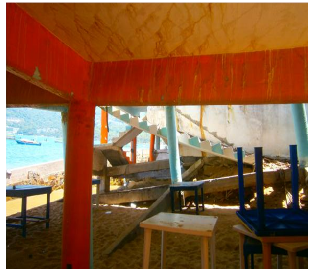
Figura 4.7. Restaurantes dañados en Puerto Marqués a raíz de la construcción del puerto Marina Majahua. En las fotos se puede observar los daños de la tormenta Manuel en 2013 y de Mar de fondo en 2015, debido a los rellenos del suelo marino la playa ha quedado más expuesta a ciclones, mareas y mar de fondo. Fuente: fotografía tomada por la autora en junio de 2015.
