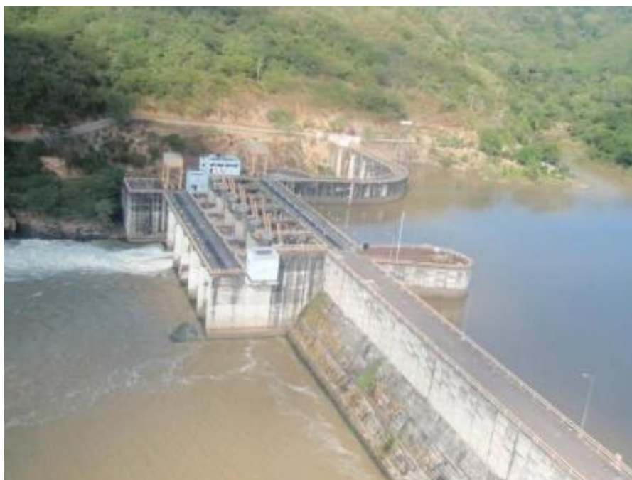
Figura 2.3 Cortina y Obra de excedencias de la P.R. San Rafael
