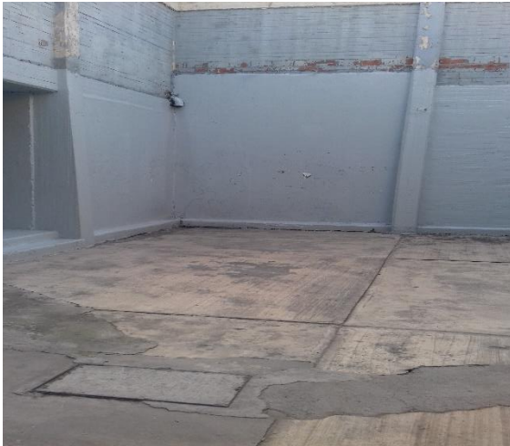
Fotografía 26. Patio en donde pueden estar los infractores del Juzgado Cívico Iztacalco 2.
