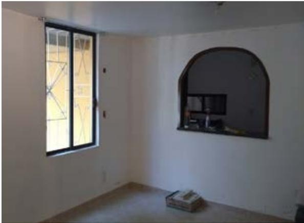
Imagen 4.46 Fotografía 02: Modificación a muro de cocina. Al fondo se aprecia parte del fregadero y una ventana añadida.
