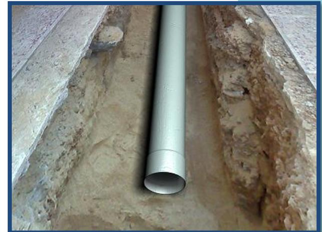
Figura 68.- Conexión Sanitaria de PVC a Red Principal
