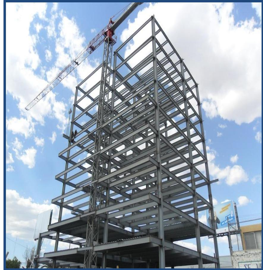
Img. 54.- Sistema Estructural a base de acero
