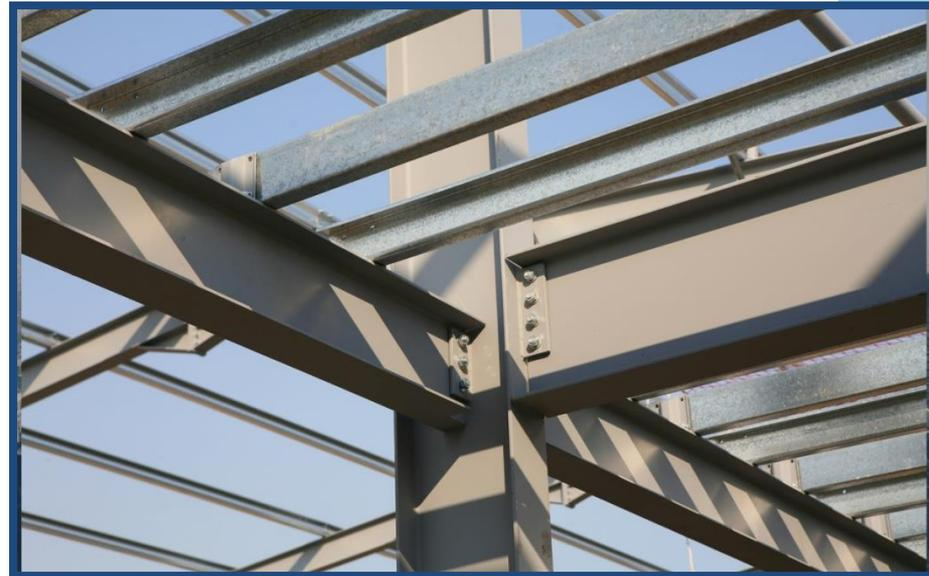
Img. 57.- Sistema Estructural a base de acero (Columna)
