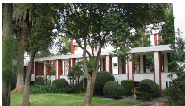
57. Andador a cubierto y jardín que regula y filtra el aire. Hospital para Tuberculosos en Huipulco. Foto LGS.
