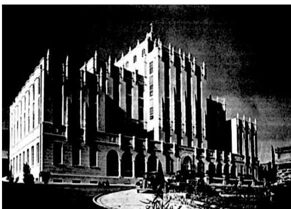
Fachada del Hospital Murguerza. Gobierno de Nuevo León, Apuntes Históricos s/f.
