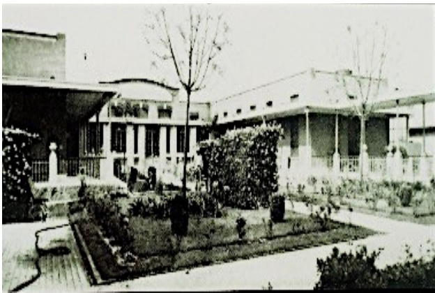
35. Circulaciones cubiertas, ventilaciones en las salas y patio interior del Hospital Francés, muestran las condiciones de habitabilidad por medios naturales. Archivo privado del Dr. Guillermo Santí.
