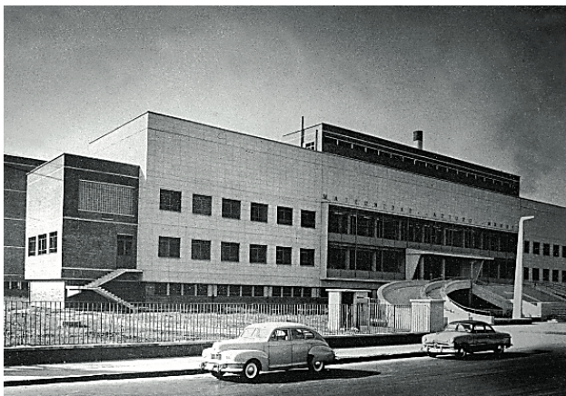
95. Fachada principal de la Maternidad Arturo Mundet con rampas de acceso.
