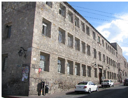
Fachada principal en perspectiva y fachada de la Escuela de Enfermería del Sanatorio de la Luz, en Morelia, Michoacán. Fotos LGS
