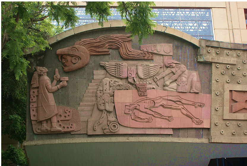
171. Detalle de las aulas en forma isóptica para acentuar que “la forma sigue a la función”, construidas en la parte noroeste. Detalle del alto relieve elaborado por el artista José Chávez Morado. Foto LGS.
