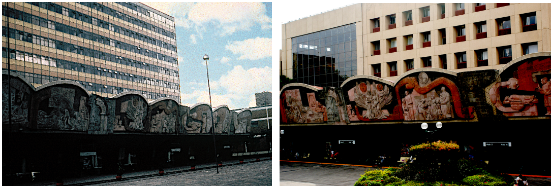
169 y 170. El edificio de especialidades, antes y después del sismo de 1985, estaba ubicado en la parte posterior de las ocho aulas de especialización del Centro Médico Nacional. Vargas Salguero Ramón, HAYUM, Vol. IV, El Siglo XX, p. 273 y foto LGS.
