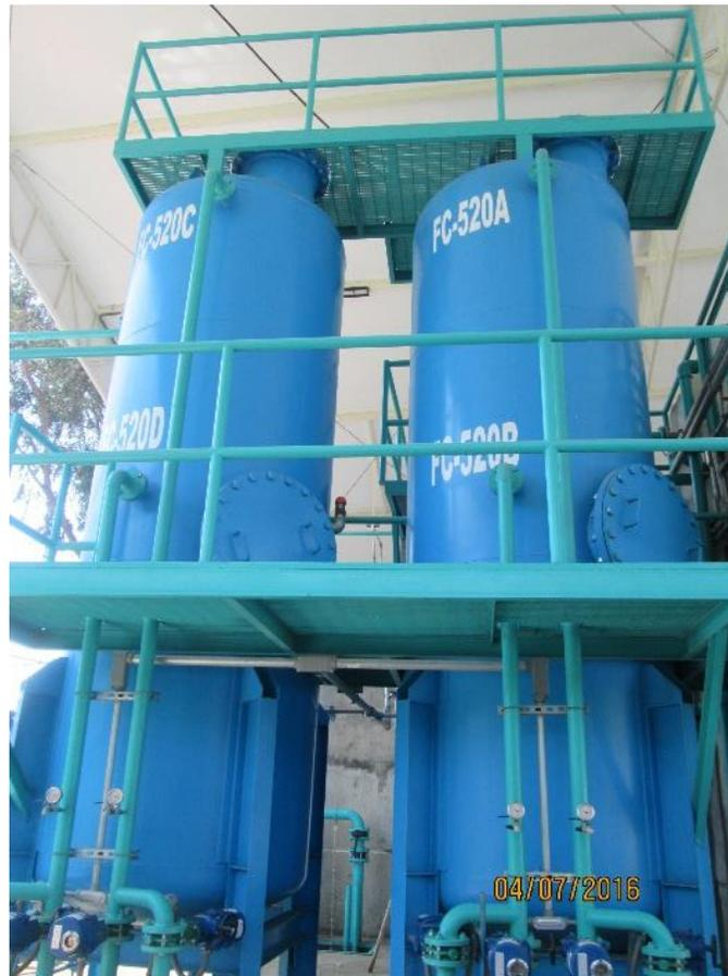
**Fig. No. 27. Filtros a presión de acero al carbón.**
