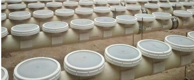
**Fig. No. 33. Difusores de aire SSI STAMFORD Tipo: AFTS3100**
