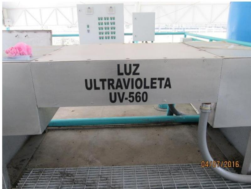
**Fig. No. 29. Sistema de Luz ultravioleta**
