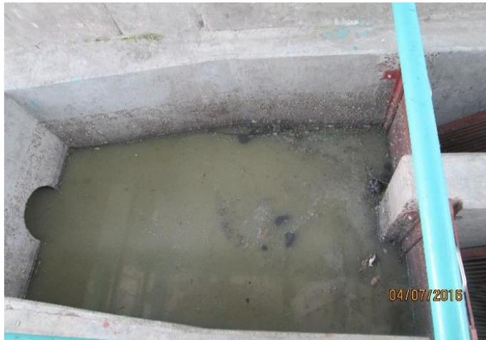
**Fig. No. 16. Entrada de agua residual al desarenador.**
