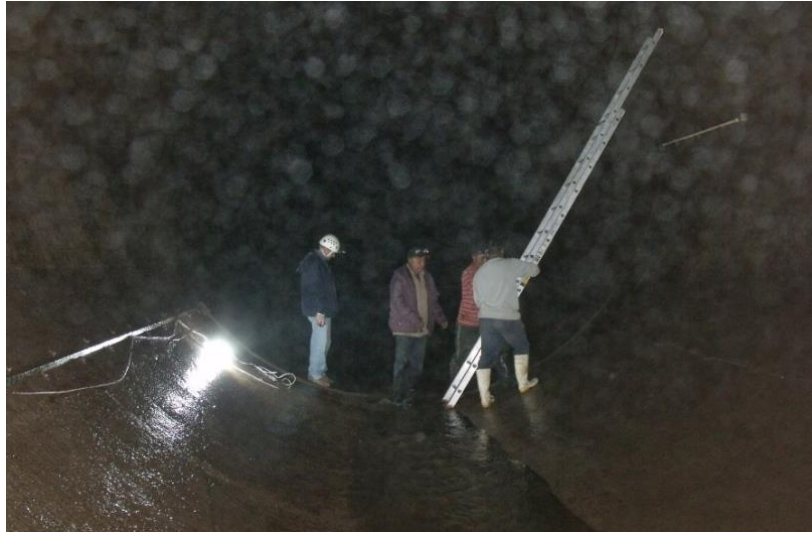
Figura 8-7 Instalación del medidor ATT en tubo 1 de Presa Palmito
