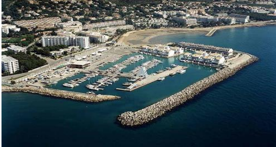
Figura 1.2.2 Dique Rompeolas de Piezas Sueltas (DRPS)
