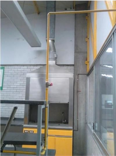
Tuberías sin banda o placa identificación ni manómetro cerca de la válvula. Al fondo tubería sin color de seguridad.
