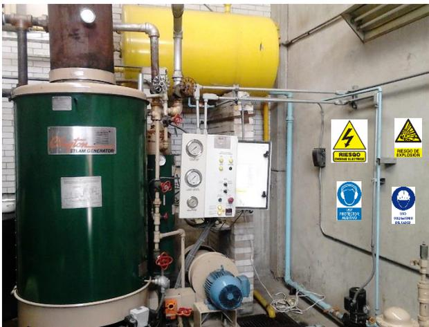
*Ilustración 130 Cuarto de máquinas “generador de vapor”*
