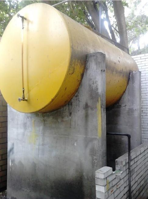
Tanque diésel sin identificar, no hay señales de higiene y seguridad de precaución de obligación e información. Tuberías sin identificar el fluido de alto riesgo que conduce.
