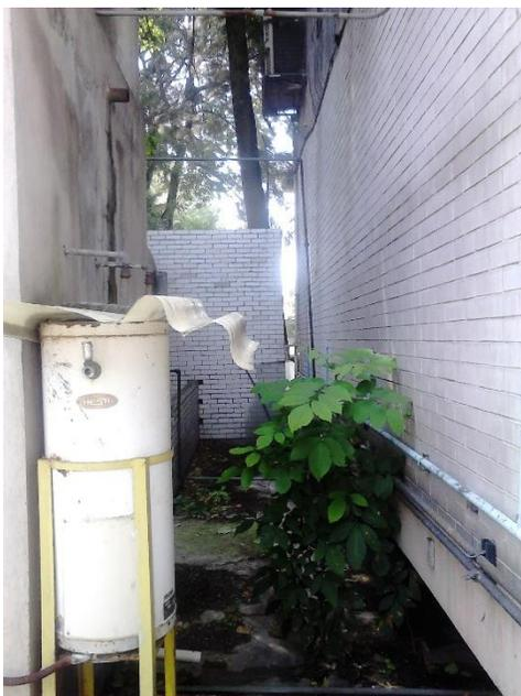
Las tuberías no se encuentran señalizadas y no hay señales de seguridad e higiene visibles.
