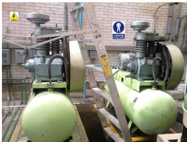
*Ilustración 131 cuarto de máquinas “generadores de vacío y aire comprimido*
