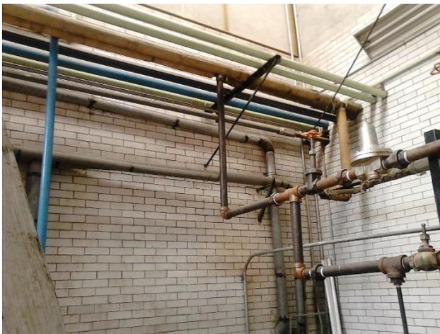
Tuberías cuarto de máquinas sin identificar y sin señales de seguridad e higiene.
