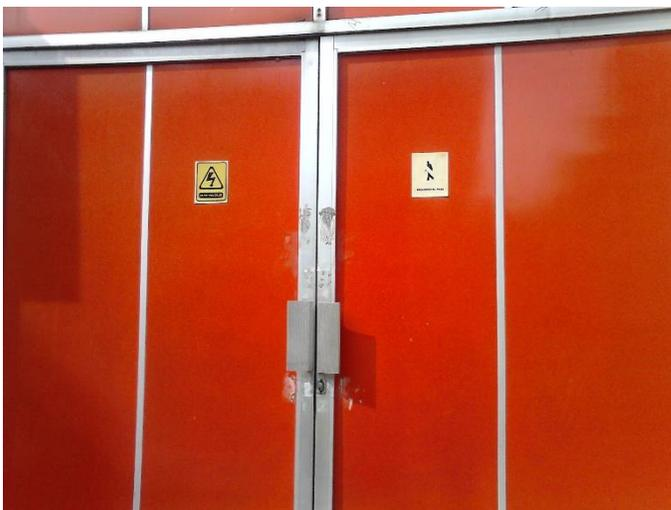
Puerta de entrada al cuarto de máquinas con señales muy pequeñas y deterioradas
