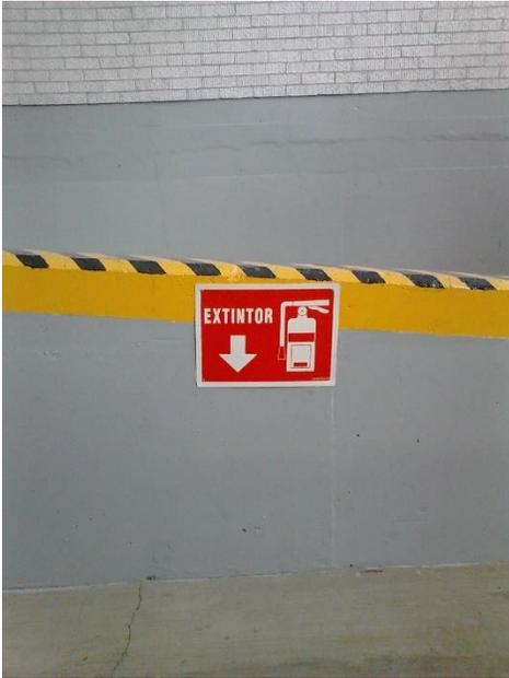
Señal de extintor sin el dispositivo extintor ABC requerido
