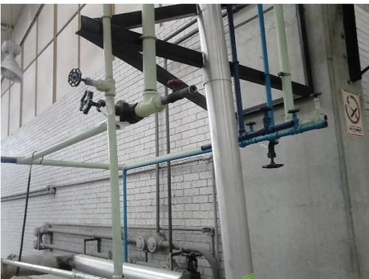
Tuberías sin placa de identificación, sin manómetros, y sin señal de sentido de flujo.
