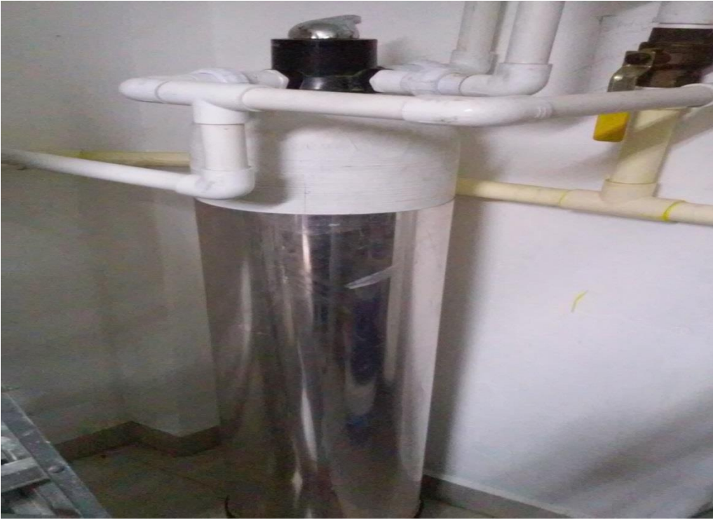
fig(6.11.2) filtro de carbón activado
