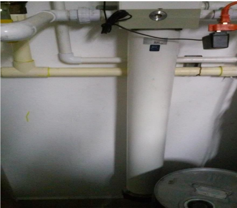
fig(6.11.4) ur. Spring; pretratamiento de UV (mantiene el E-coli fuera del agua)
