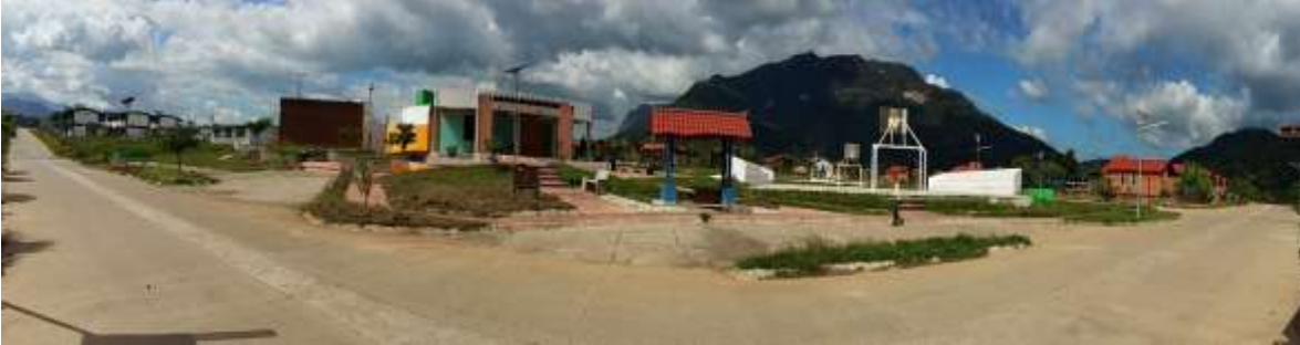
Foto 32 Vista general del equipamiento de Jaltenango
