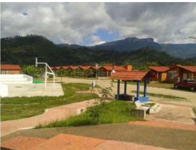
Foto 33 Vista general del equipamiento de Jaltenango
