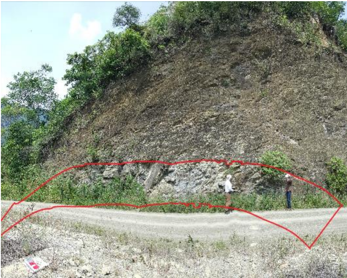
Figura 4.25 Falla inversa sobre la terracería al poblado de Tula, se muestra la superficie de falla de color rojo, la litología de abajo son calizas de la Formación Tamaulipas y la de arriba son lutitas de la Formación Tuzancoa.
