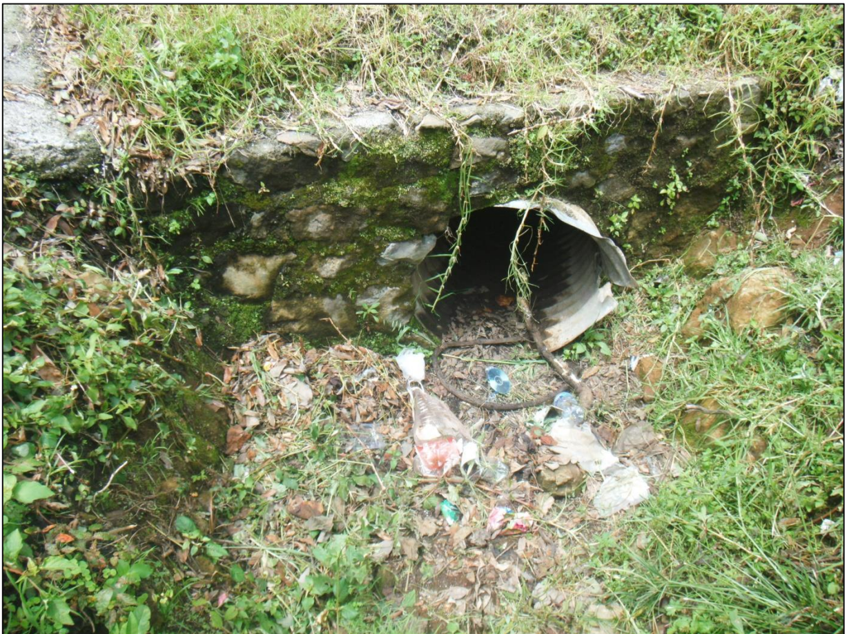
Fotografía 3.3.- Tubería actual del km 33+005.
