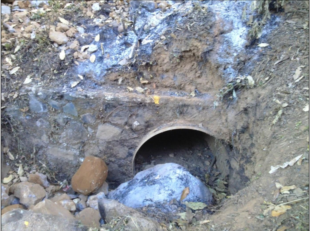
Fotografía 3.4.- Tubería actual del km 33+445.
