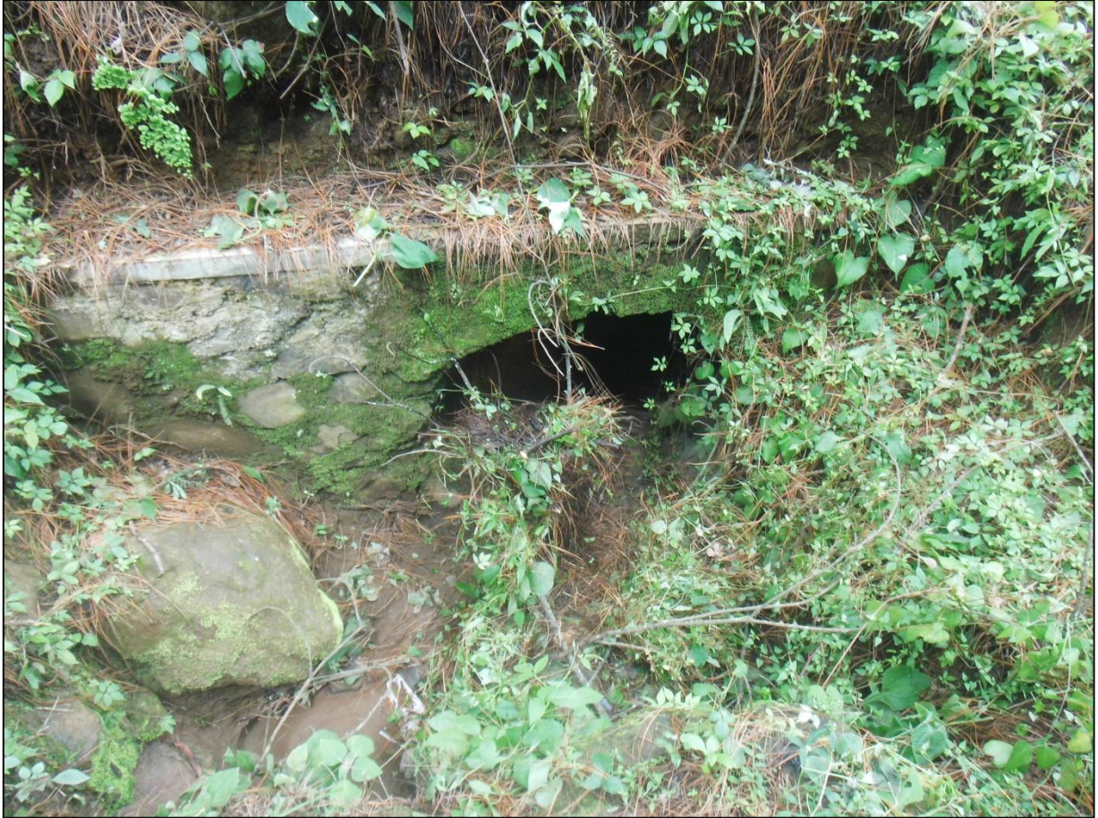
Fotografía 3.2.- Tubería actual del km 32+775.
