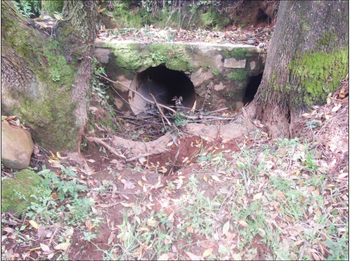
Fotografía 3.1.- Tubería actual del km 30+215.
