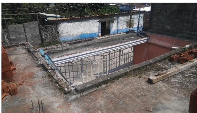
Imagen 3.9. Se observa la parte de la losa y su terminado.
