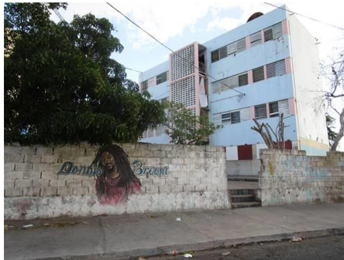
Ilustración 21 Complejo habitacional de Rema, considerado Garrison Community
