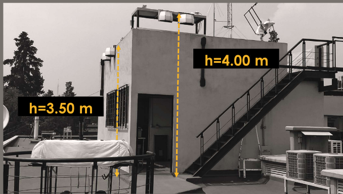
Figura 25. Colocación de piranómetros. Elaboración propia.
