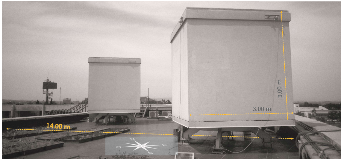
Figura 27. Dimensiones de la azotea de Posgrado y módulo. Elaboración propia.
