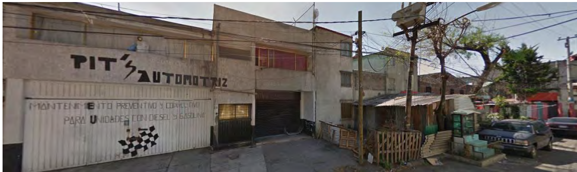
Imagen 4.11. Vista de viviendas en calle Panamá. Asentamientos irregulares obstaculizan la vía pública.
