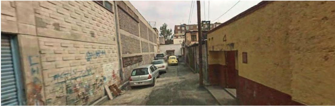
Imagen 4.10. Vista de viviendas en calle Bolivia. Se puede percibir su mal estado e inseguridad
