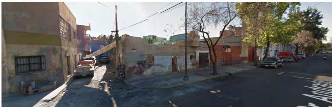
Imagen 4.12. Vista de viviendas en calle Dr. Andrade, mismas que dan una mala imagen urbana.
